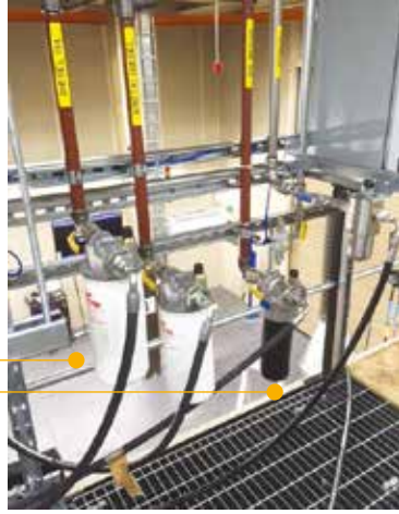
LMP210 在线过滤器和 MPS 旋转过滤器，适用于柴油、机油、尿素溶液等流体
