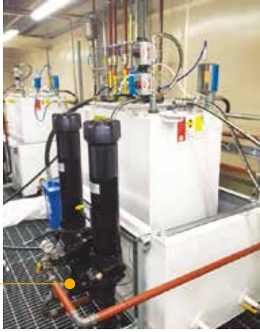
液压油箱配置 LMD431 在线双联过滤器
